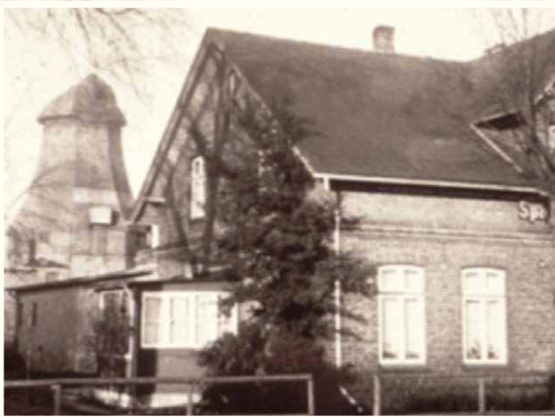
Die Osdorfer Mühle vor über 100 Jahren
